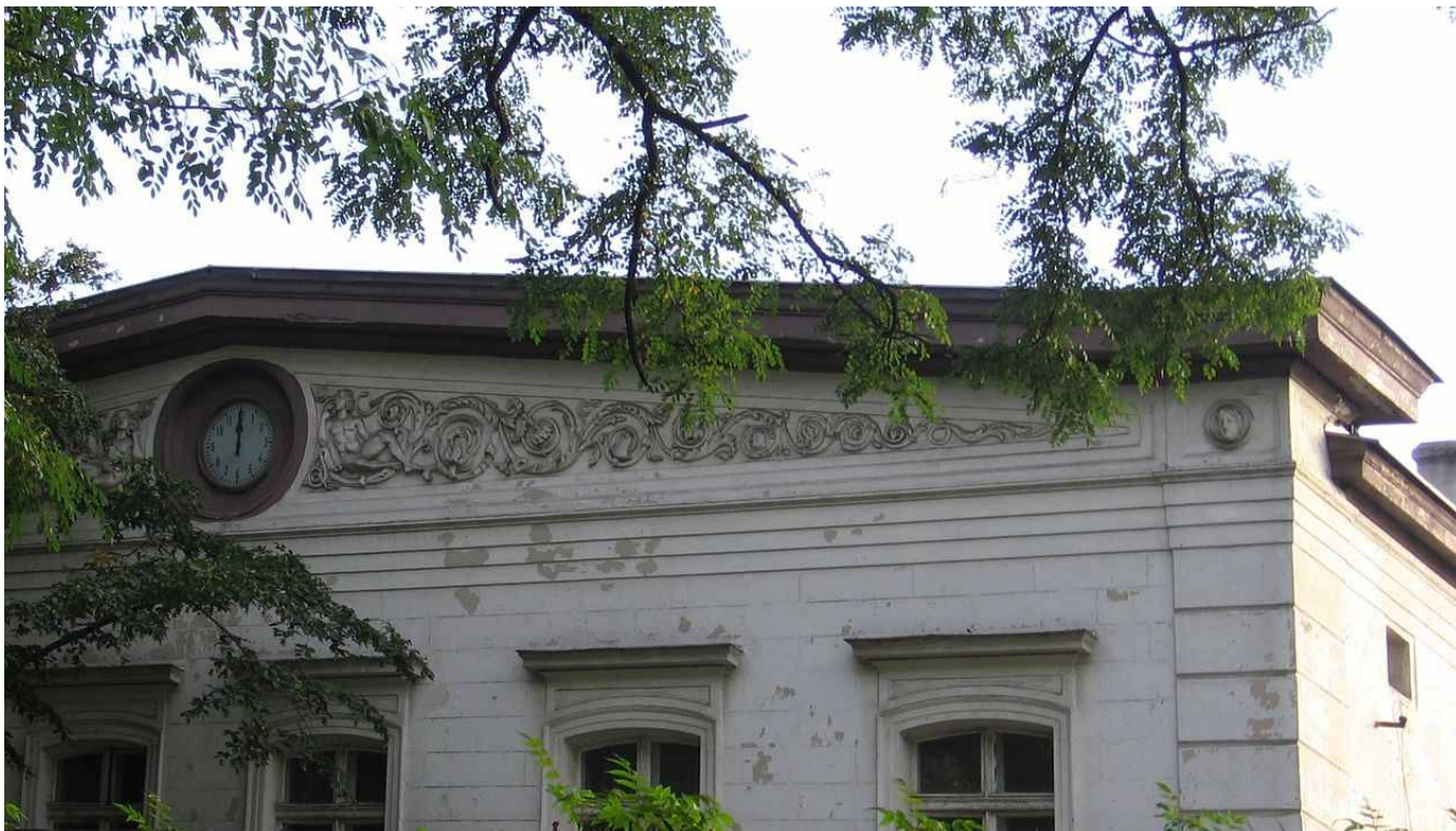
Zabytkowa fasada Dworca Górnśląskiego. Fot. PKP TELKOL.
