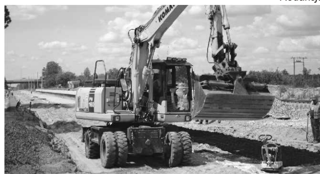
Prace na modernizowanej linii kolejowej nr 7. Fot. PKP TELKOL.
