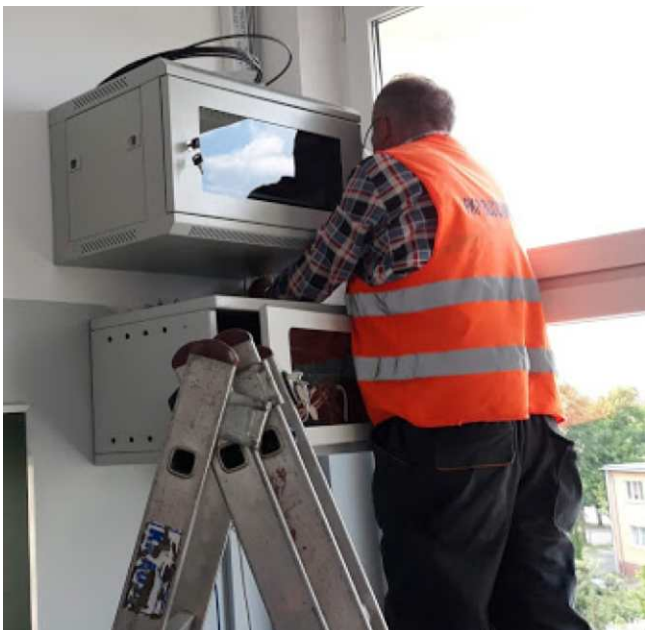
Montaż szafki kablowej w szkole
