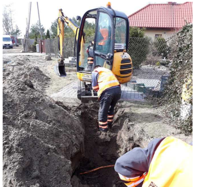
Budowa kanalizacji kablowej
